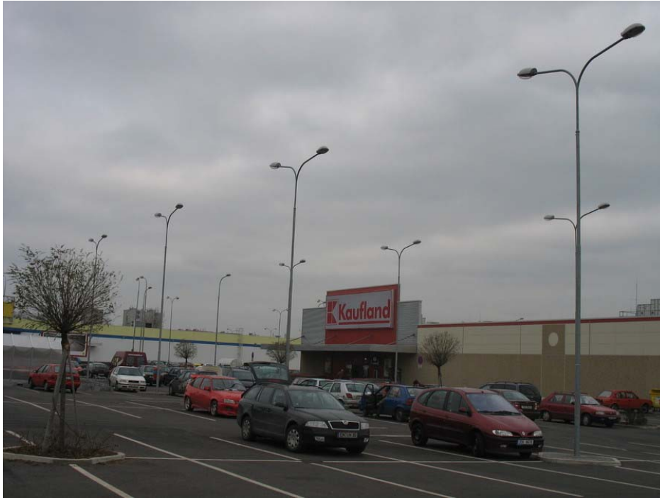
Obr. 11.2 Osvětlení parkoviště u obchodního domu silničními svítidly na stožárech
