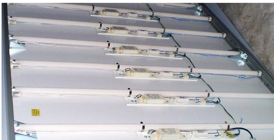
Obr. 5.20 Prosvětlovaný panel – vnitřní část
