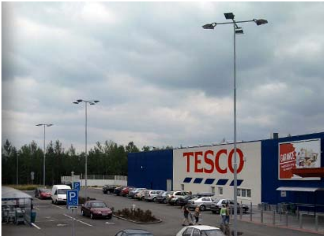
Obr. 11.3 Osvětlení parkoviště u obchodního domu světlomety na stožárech
