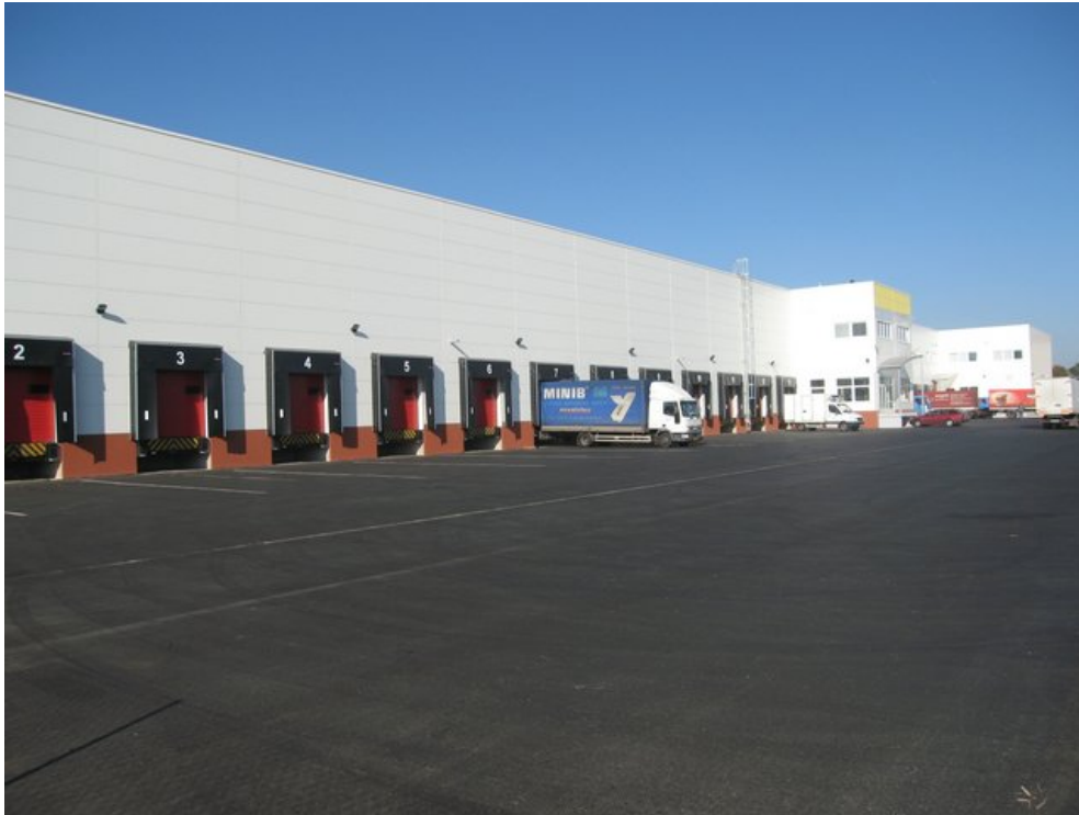
Obr. 11.1 Osvětlení komunikačního prostoru před nakládací rampou světlomety na fasádě
